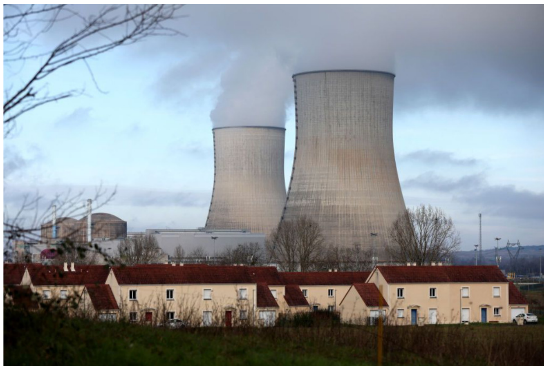
Dwie wieże chłodzenia elektrowni jądrowej Civaux w środkowej Francji
